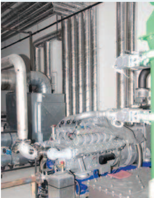
Im Vordergrund ist der Motor des BHKW zu sehen, im Hintergrund Teile des Abgasreinigungssystems (Katalysatoreinheit).
