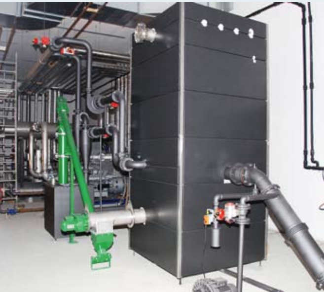
In der Heißgasfiltereinheit mit seitlichem Ascheaustrag wird das erzeugte Holzgas von Partikeln gereinigt.
